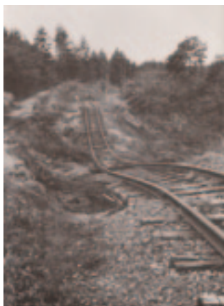
十勝沖地震によって宙づりになった線路（南部鉄道五戸線）
