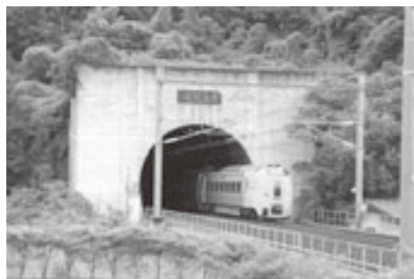
本州側青函トンネル出入口（今別町）
