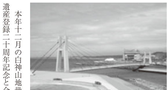
はまなす公園と新設海浜公園を結ぶ「なぎさ・ブリッジ」
