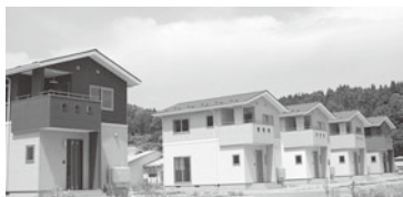
完成が近い定住促進住宅
