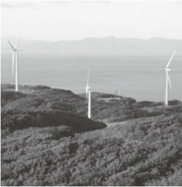
▲外ヶ浜町の風力発電機
