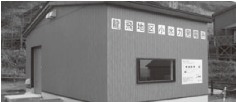
▲龍飛地区小水力発電所
