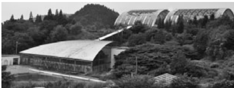
廃業したリゾート施設跡地
