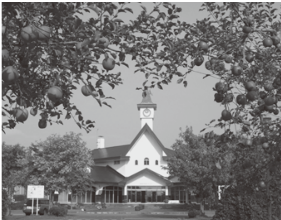
町の産業振興の拠点「板柳町ふるさとセンター」本館
